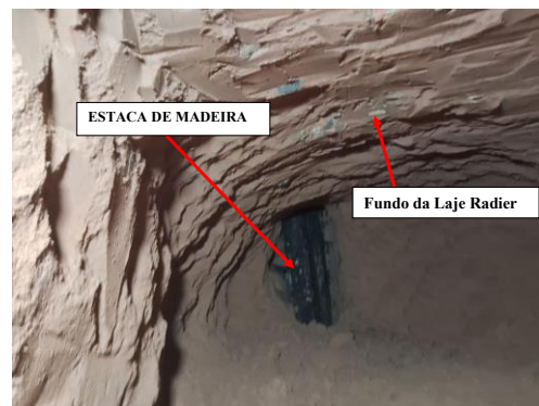
Figura 10 – Vista sob a laje radier (Acervo próprio)
