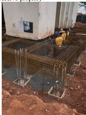
Figura 26 – Armação das vigas de borda (Acervo próprio)
