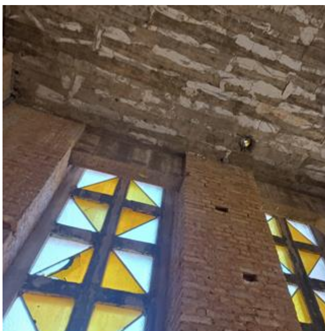
Figura 7 – Vista interna da superestrutura (Acervo próprio)
