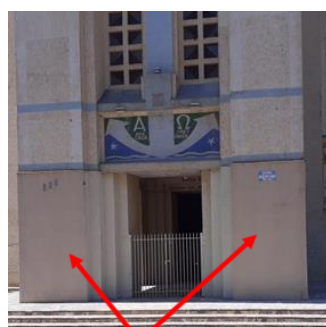
Núcleo Estrutural em Alvenaria
