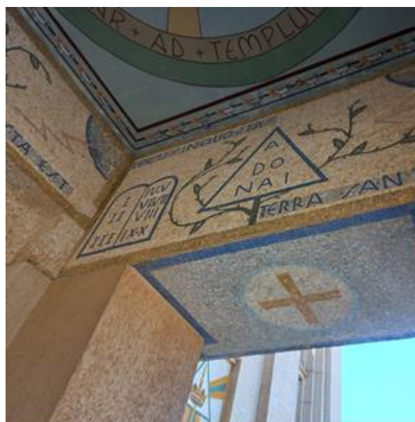
Figura 8 – Vista interna da superestrutura no pavimento térreo (Acervo próprio)
