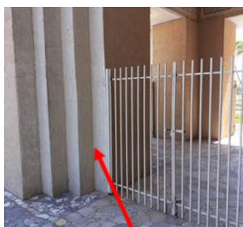
Núcleo Estrutural em Alvenaria
