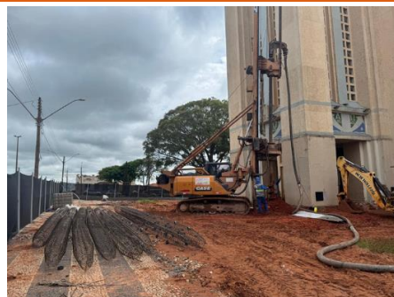
Figura 25 – Colocação da armação das estacas tipo hélice (Acervo próprio)
