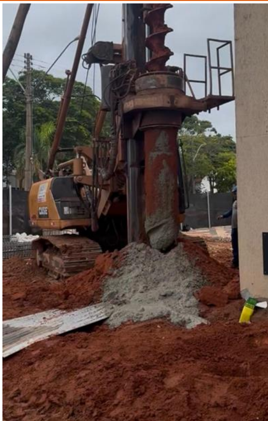
Figura 24 – Escavação das estacas tipo hélice (Acervo próprio)
